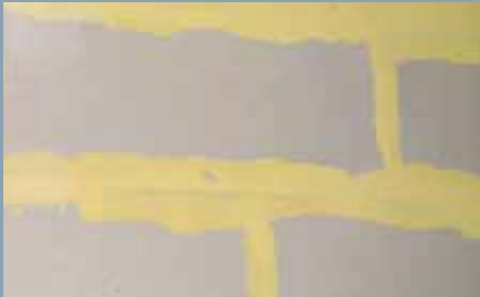
Verspachtelung mit gelbem Safeboard-Spachtelmaterial für höchste Sicherheit
